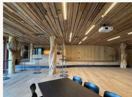
Fest installierter Beamer, Leinwand, Musikanlage und Mikrofon
